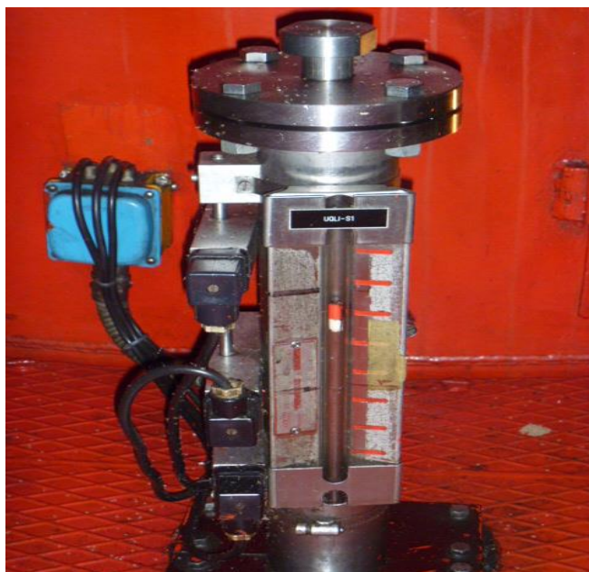
Figura 3. Indicador de nivel en la cuba del cojinete guía.
